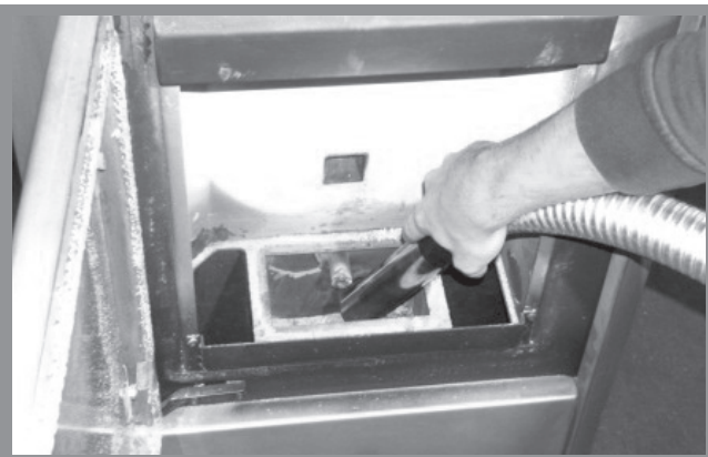
Abb. 12f: Reinigung Brennraumbehälter
