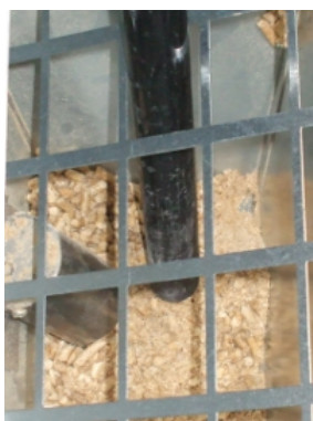
Fig. 74 - Reinigung Tank und Schnecke
