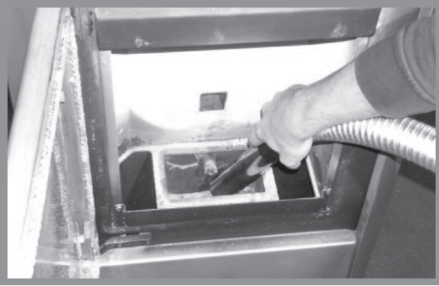
Abb. 12f: Reinigung Brennraumbehälter
