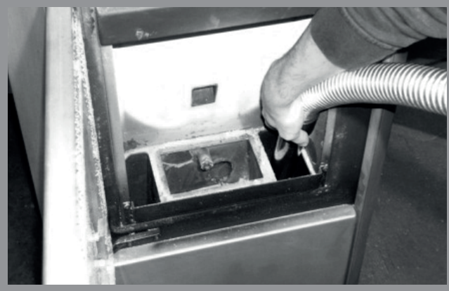
Abb. 12g: Reinigung untere Brennkammer
