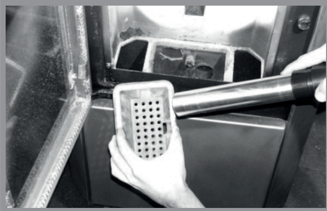
Abb. 12b: Reinigung der Luftöffnungen mit einem Staubsauger
