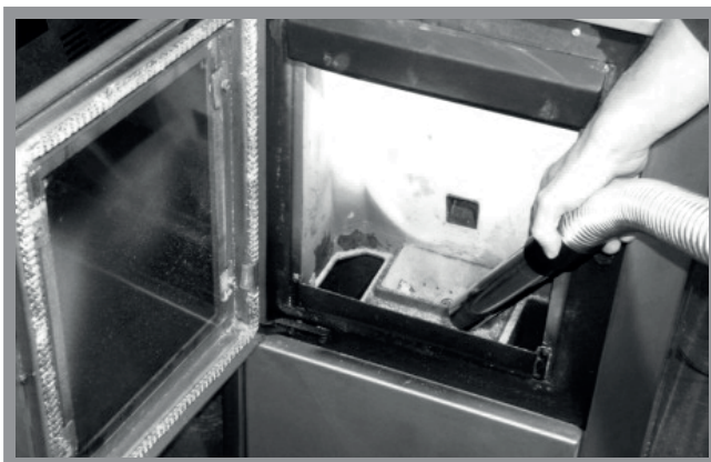
Abb. 12a: Reinigung des Brenntopfes
