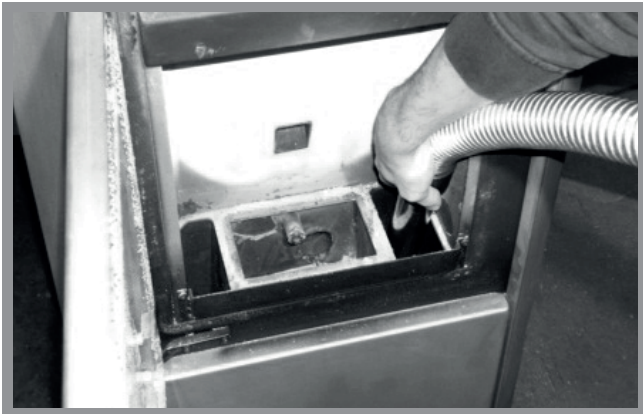
Abb. 12g: Reinigung untere Brennkammer
