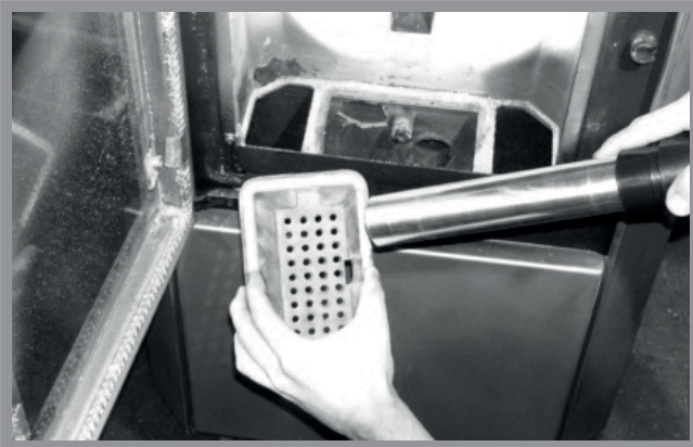
Abb. 12b: Reinigung der Luftöffnungen mit einem Staubsauger
