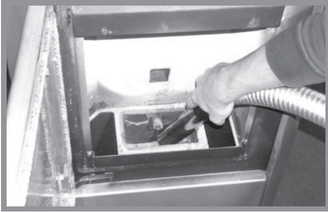
Abb. 12f: Reinigung Brennraumbehälter
